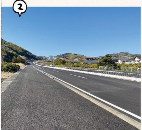
2月20日に開通した中部横断道のアクセス道路
