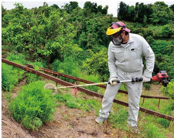
傾斜のある場所の草刈りは足場の安全を確認し、ゴーグルや手袋を着用。刃に絡みついた草などを取る場合は、必ずエンジンを止める。
