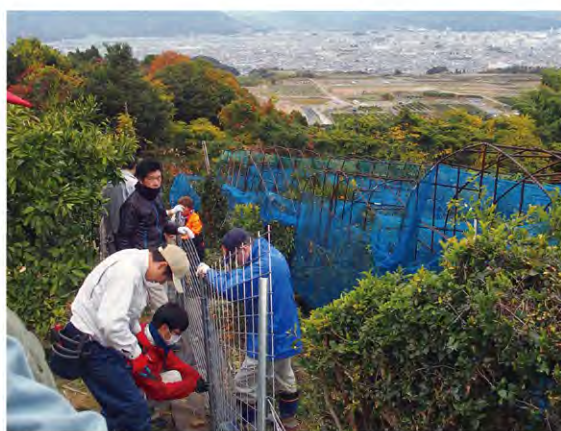
▲鳥獣被害対策の防護柵を設置する受講者ら
