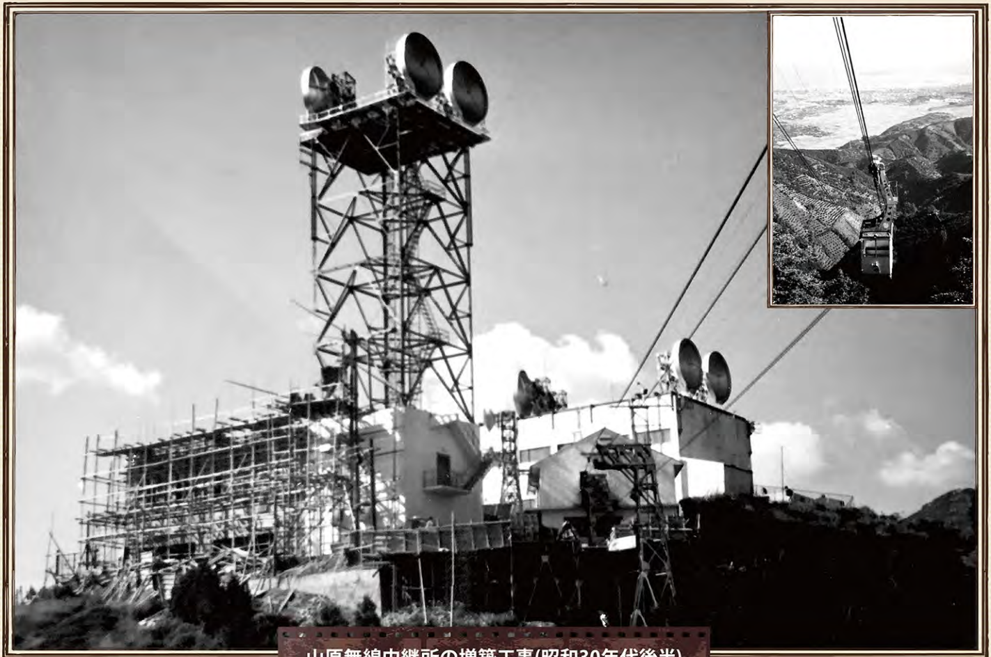
山原無線中継所の増築工事(昭和30年代後半)
