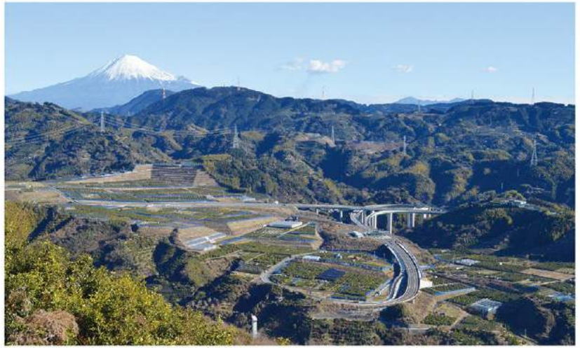
■大規模な土地改良が行われた原・新丹谷地区。以前は急傾斜な山だったが、平たんになったことで品質や作業効率が上がった。
