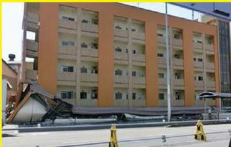
1階が崩れ、押しつぶされたマンション (熊本県上益城郡益城町)
