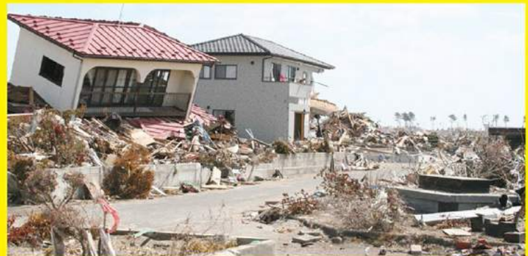
地震と津波で倒壊した家屋 (宮城県仙台市)
